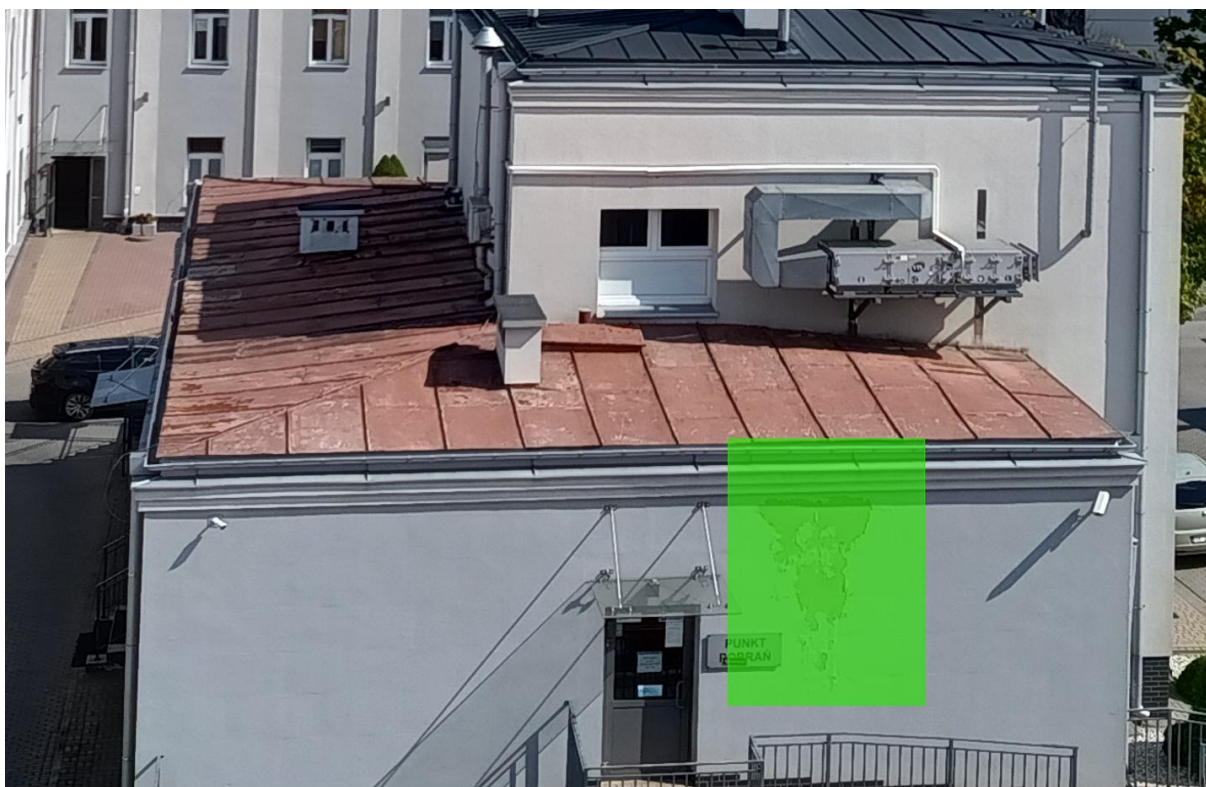
Zdjęcie obrazujące lokalizację zacieków elewacyjnych oraz złuszczenie warstw elew.
